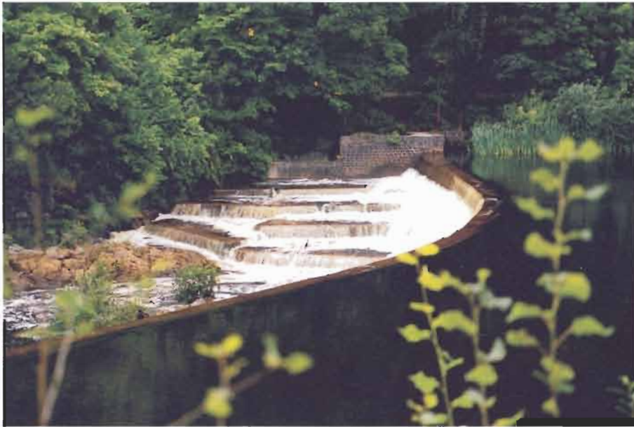
Die älteste, noch funktionsfähige Lachstreppe der Provinz (Sperlingsholm). Erbaut um die Jahrhundertwende.
